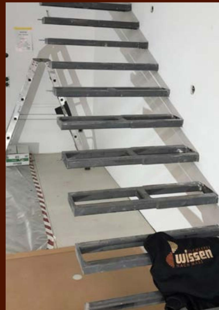
Im Rohbau verankerte Stahlgelgen an der Betonwand
