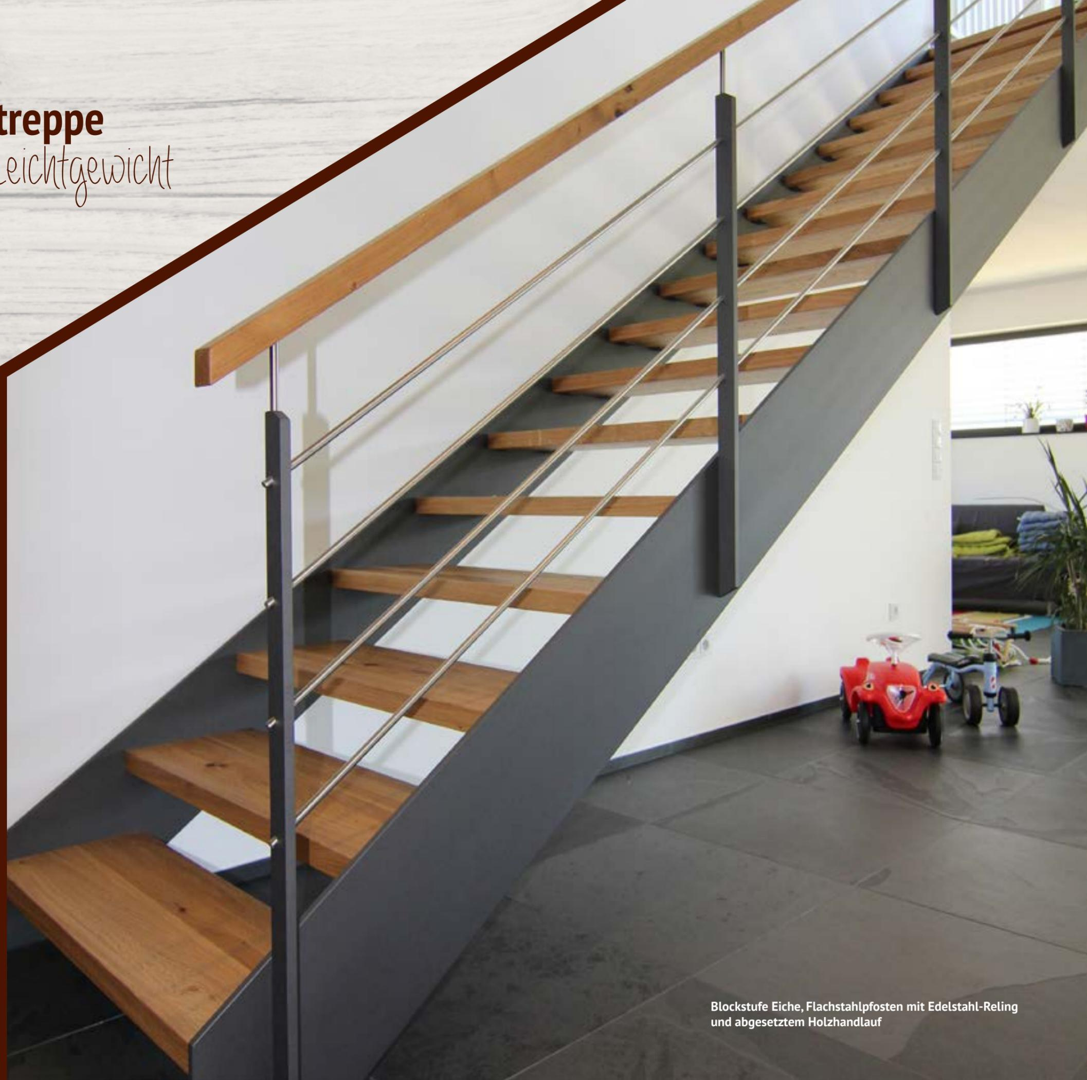
Blockstufe Eiche, Flachstahlpfosten mit Edelstahl-Reling und abgesetztem Holzhandlauf
