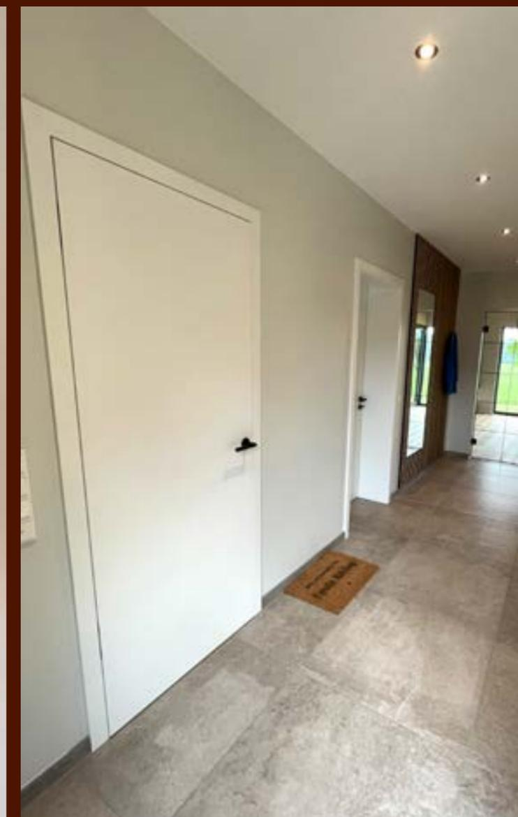
stumpf einschlagende Innentür, mit verdeckt liegenden Bändern und Magnetfallschloss, ohne Schlüssellochbohrung
