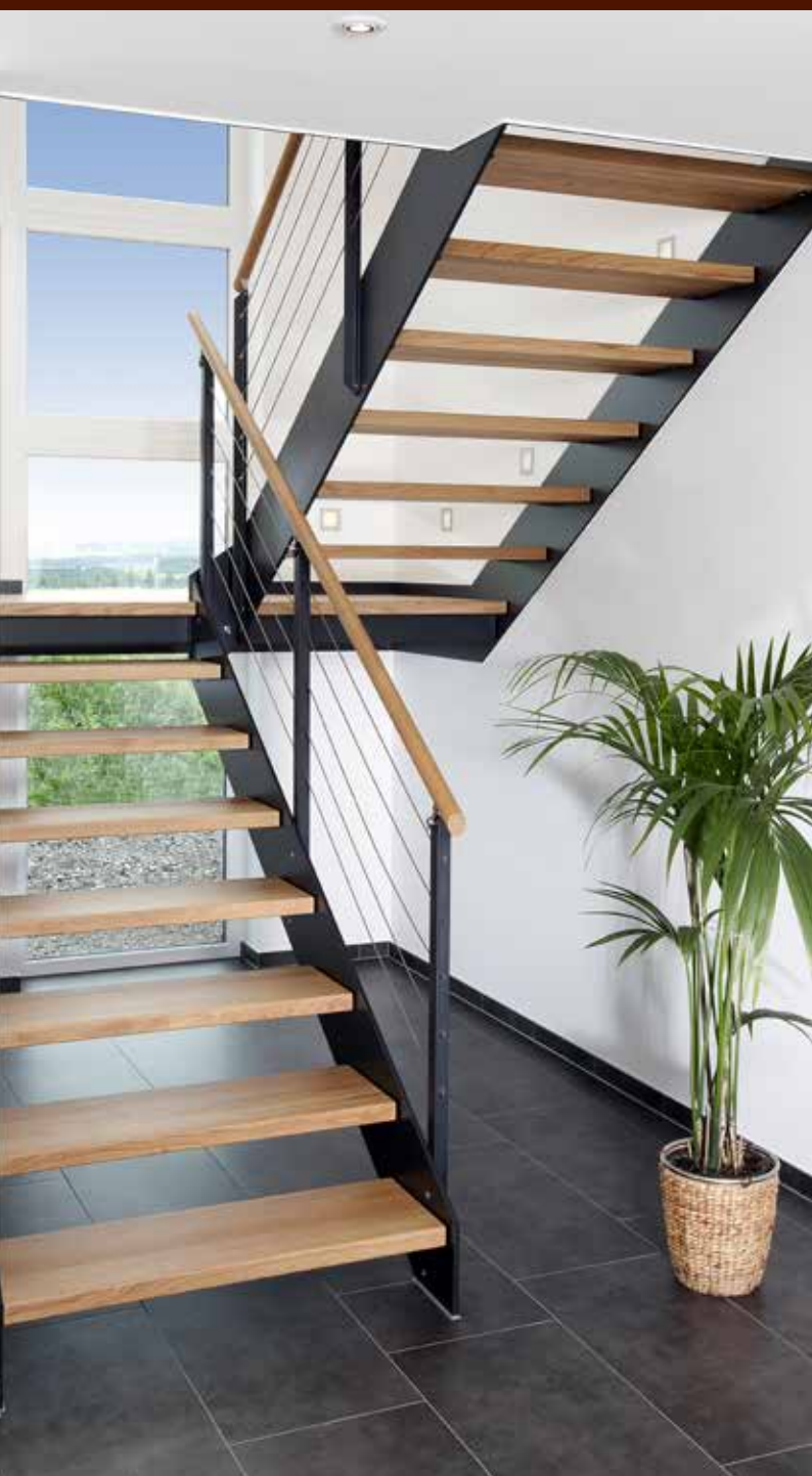
Reling aus Edelstahlseilen mit abgesetztem Holzhandlauf
