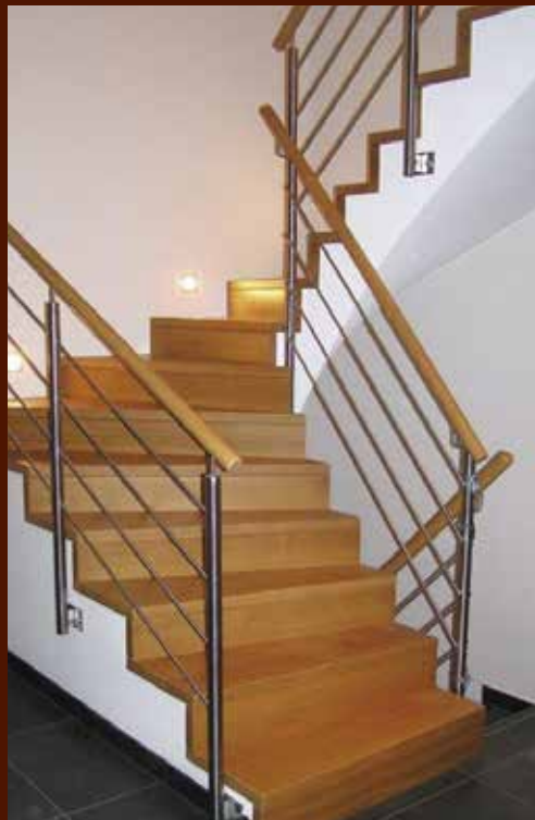
Edelstahlgeländer mit abgesetztem Handlauf aus Holz
