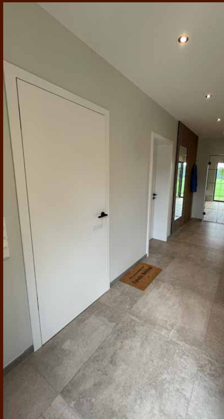
stumpf einschlagende Innentür mit verdeckt liegenden Bändern und Magnetfallschloss ohne Schlüssellochbohrung
