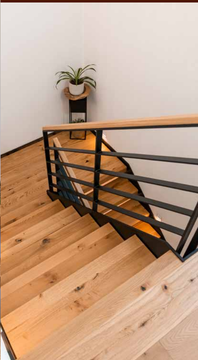
Flachstahlgeländer gepulvert, mit aufgesetztem Holzhandlauf.
