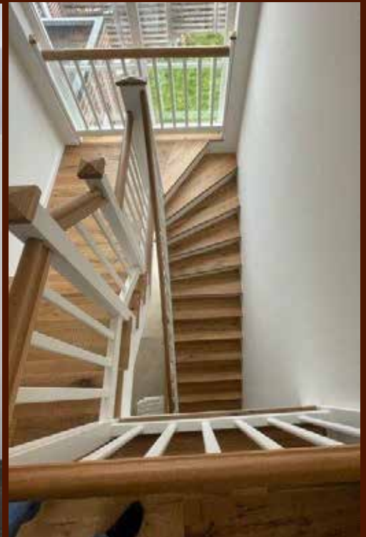
Handlauf mit Omegaprofil für einen guten Griff.
