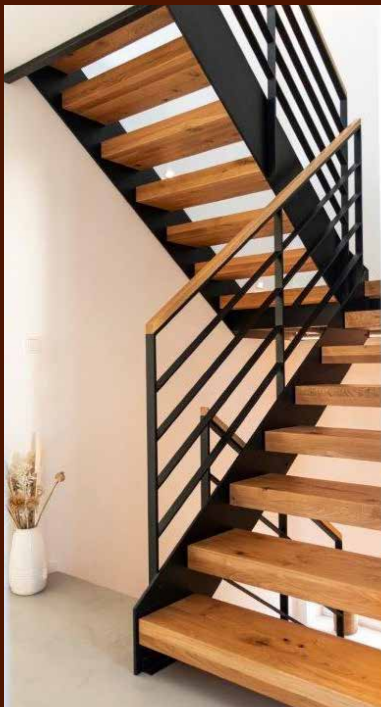
Blockstufe Eiche astig. Durch die doppelte Stufenstärke, verringern sich die Steigungsabstände der einzelnen Stufen.
