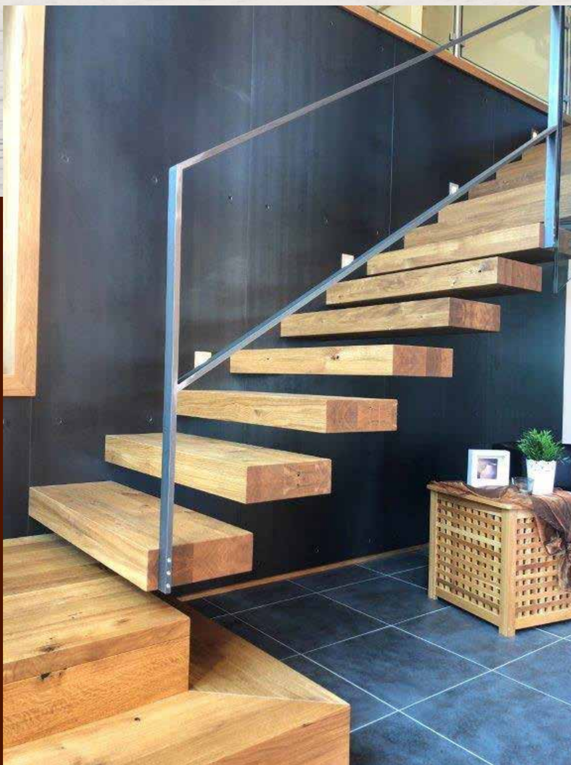
Kragarmstufen in Eiche astig mit edlem Flachstahlgeländer in minimalistischer Ausführung.
