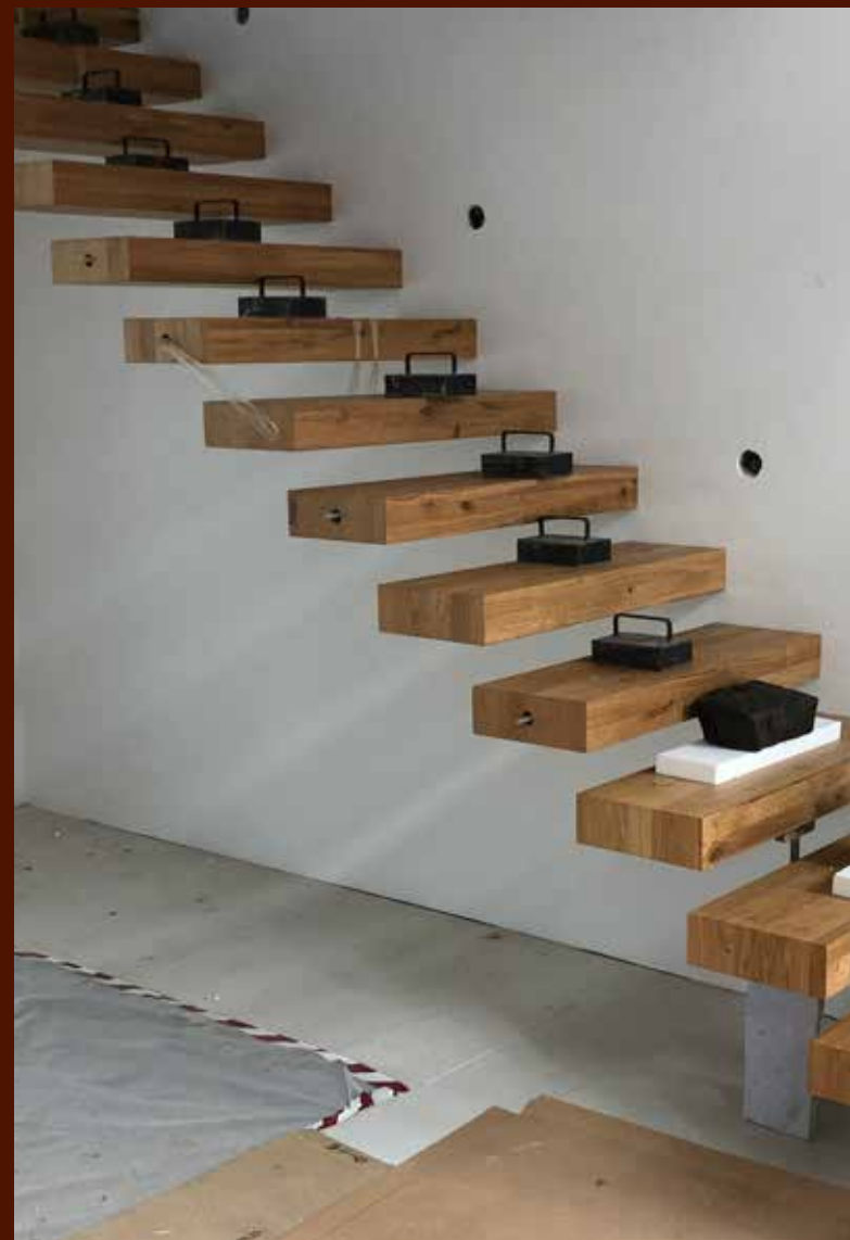
Endmontage der Kragarmstufen aus Eichenholz.
