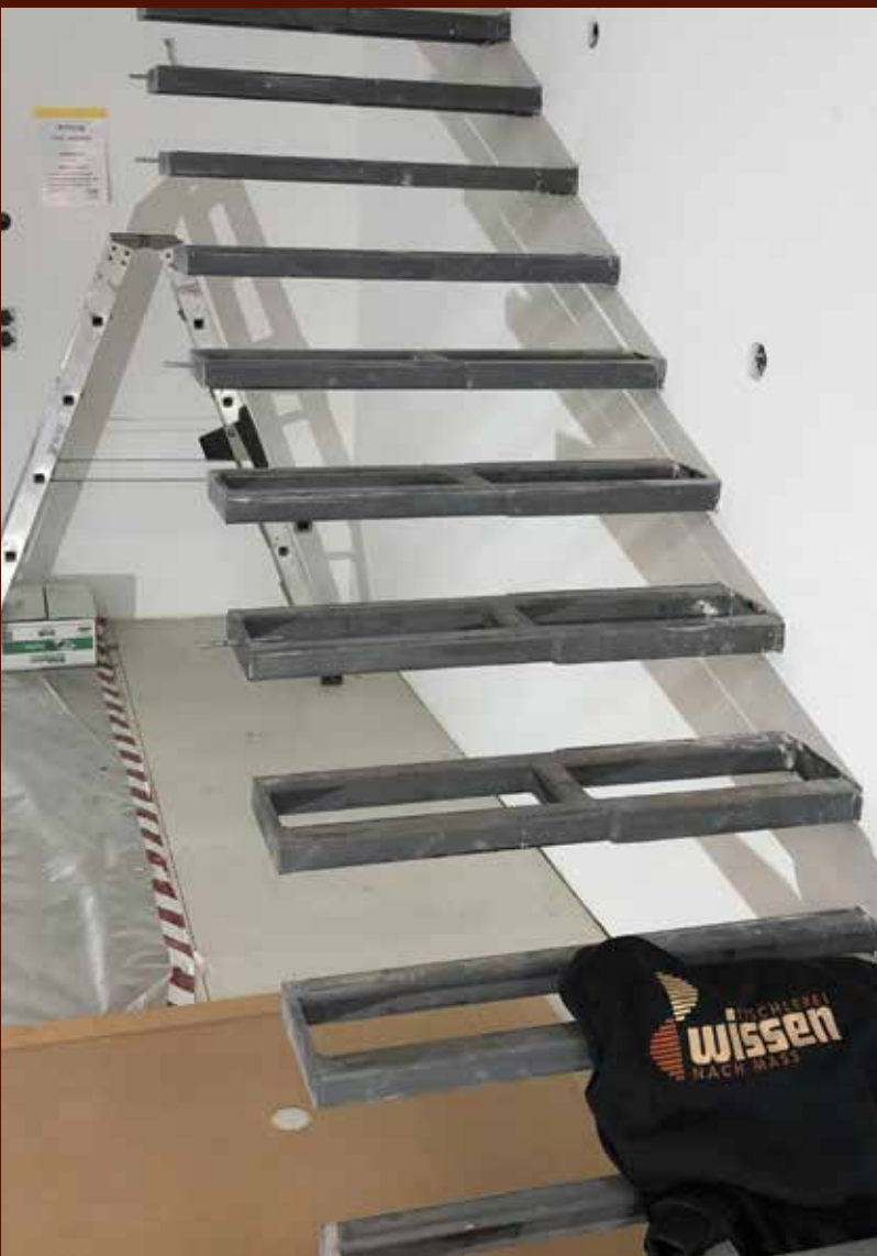
Im Rohbau verankerte Stahlgalgen an der Betonwand
